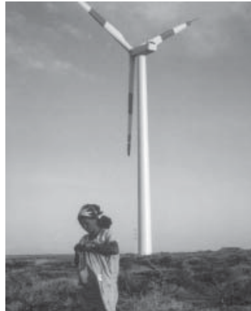
Con el proyecto de generación eólica Jepírachi, las Empresas Públicas de Medellín entran a la era de las energías no convencionales
