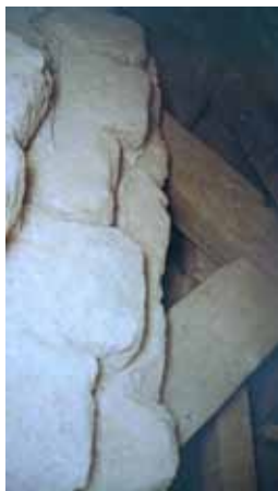
Fig. 9. Bóveda central de la macsura: trasdós de su cúpula central apoyada sobre vigas de madera.
