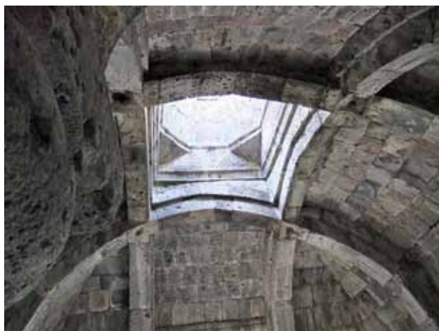
Fig. 11. Monasterio de Haghpat (Armenia): bóveda del refectorio.
