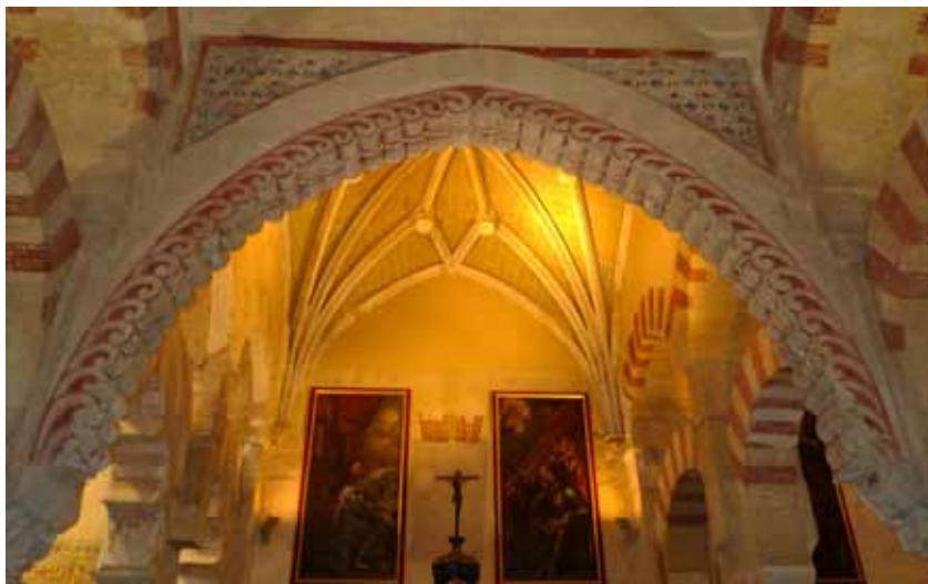
Fig. 13. Ampliación de Al-Hakam II: arco apuntado de la arquería transversal.
